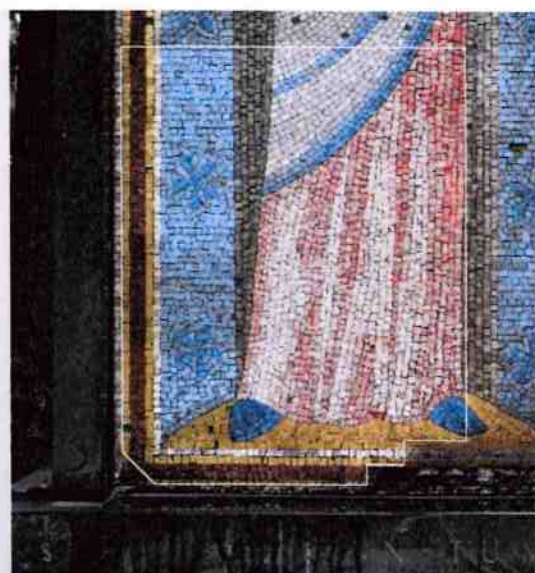
Zkouška čištění mozaiky na náhrobku Jana Tumpacha na Vinohradském hřbitově
